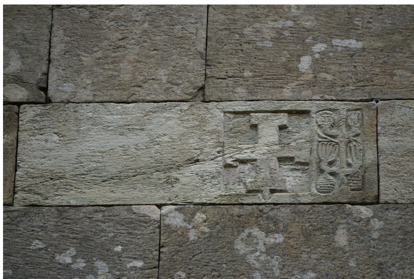
Fig. 6. Vicopisano, San Jacopo di Lupeta, concio scolpito sul fianco dell'edificio.
