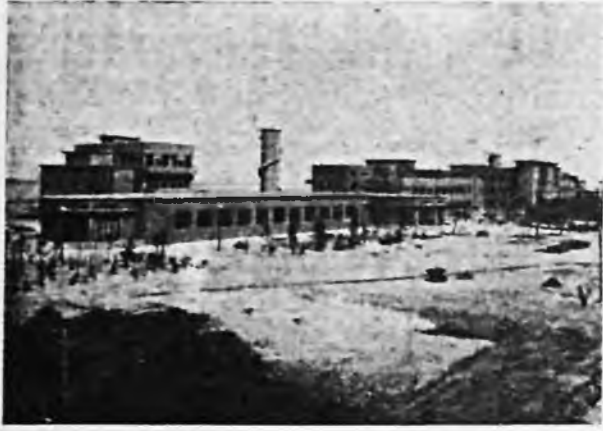
ARCH. ANGILO MAZZONI VEDUTA GENERALE DELLA COLONIA PERMANENTE PER I FIGLI DEI FERROVIERI E DEI POSTELEGRAFONICI
