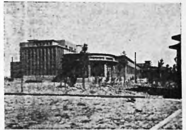
ARCH. ANGILO MAZZONI PARTICOLARE DELLA COLONIA PERMANENTE PER I FIGLI DEI FERROVIERI E DEI POSTELEGRAFONICI
